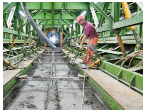
250 000 mètres cubes: c'est la quantité de béton livrée par Vigier pour la construction du tunnel de l'A5 à Bienne.
