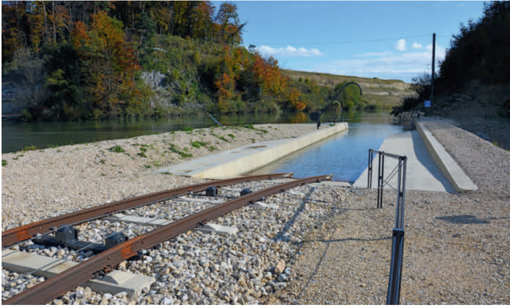
Beton für Boote: Für die Boottransportanlage in Hagneck lieferte Vigier eingefärbte Bahnschwellen.
