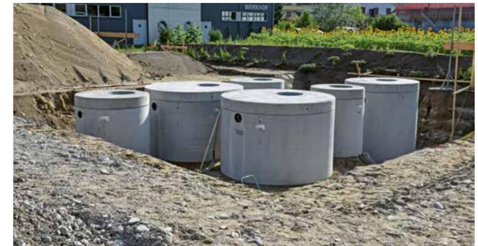
Dank Mineralölabscheidern aus Beton lassen sich ölhaltige Flüssigkeiten aus dem Abwasser entfernen und der Verwertung zuführen.
