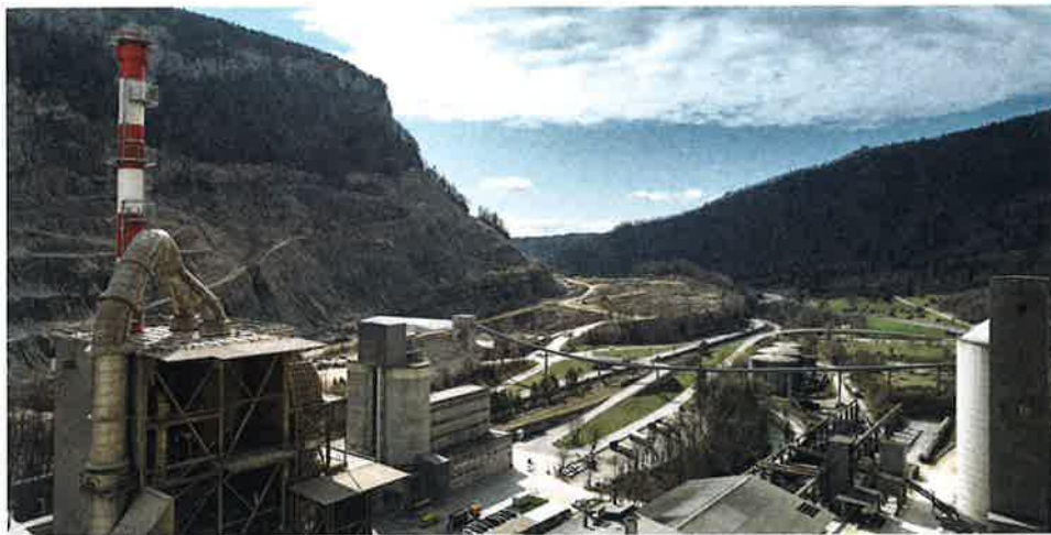
Am Standort Péry-Reuchenette (BE) wurden die CO 2 -Emissionen seit 1990 um 34 Prozent reduziert. Bis 2021 sollen es 40 Prozent werden.
