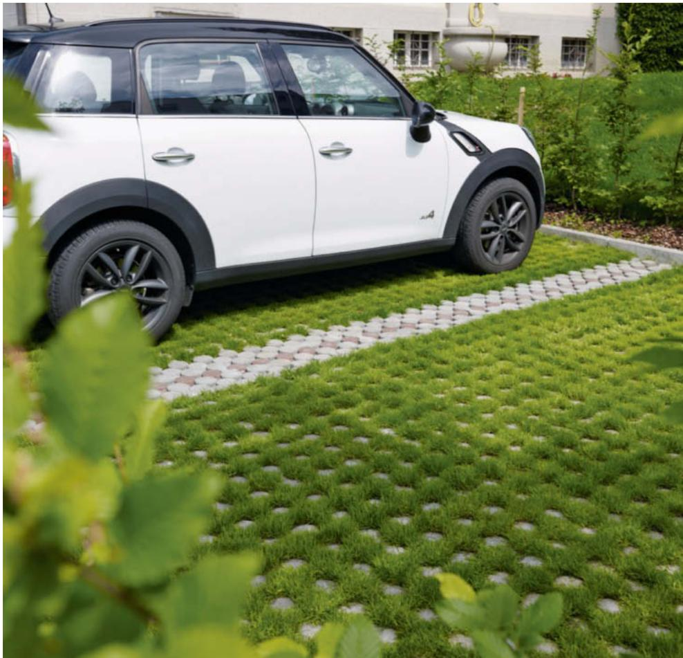
oder durch die Fugen zwischen den Pflastersteinen, die wahlweise mit Gras oder Splitt gefüllt sind. Alle diese Beläge verfügen über sehr gute Sickerwerte und werden den in der Schweiz auftretenden Niederschlagsmengen gerecht.
