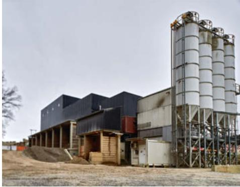
**Direkt neben der Baustelle:** Kieswerk und Betonzentrale für den Bau des Bahntunnels in Rosshäusern.
